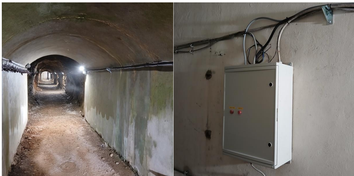
Slika: Nova razsvetljava tunela in nova krmilna omarica za pogon črpalke VH Starod vas.
