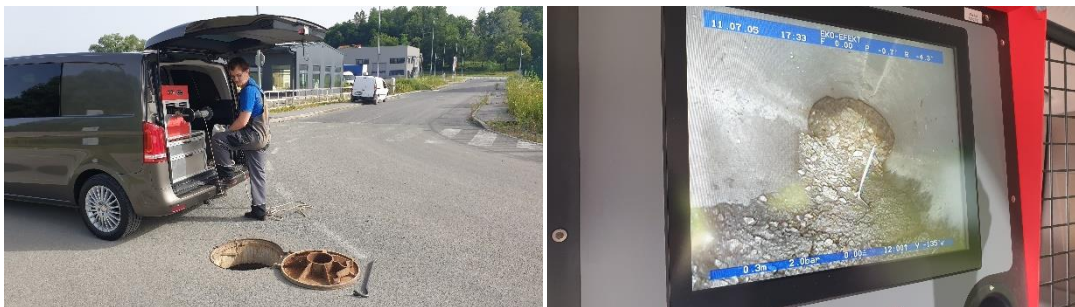
Slike: video pregled kanalizacije
